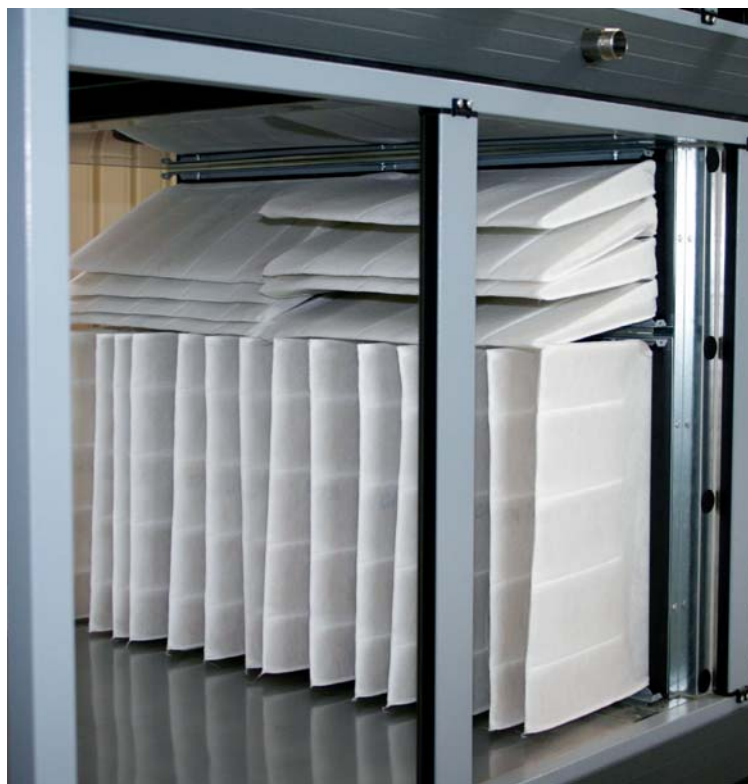
Abbildung 1: Zum Sicherstellen einer gewünschten Hygiene der Zuluft und deren Gehalt an Stäuben und gasförmigen Verunreinigungen hat eine hochwertige, oft mehrstufige Luftfiltration im RLT-Gerät eine zentrale Bedeutung. (Abb. © cci Dialog GmbH)
